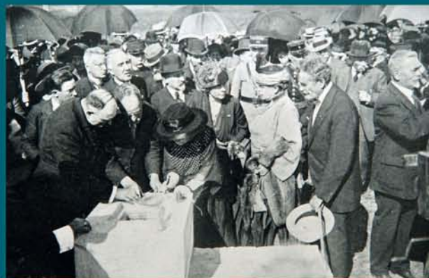
21 mai 1922 : pose de la première pierre. Photo. Coll. S.A.V.R.
