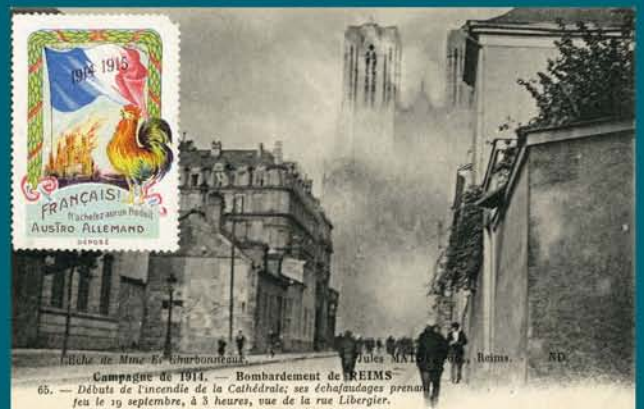
Début de l'incendie de la Cathédrale; ses échafaudages prenant feu le 19 septembre, à 15 heures, vue de la rue Libergier. CPA, Ed. J. Matot, Reims. Coll. L. Antoine.
