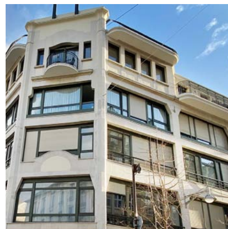
27-29, rue de Talleyrand, Reims. Arch. Viard & Dastugue. 1924-1925. Photo L.A.
